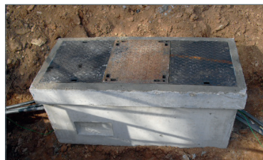
Chambre fermée - 3 tampons travaux en cours
