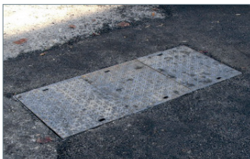
Chambre travaux finalisés 3 tampons
